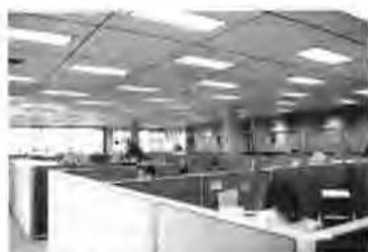
3 按照顶棚模数配置的带有铝格栅的嵌入式荧光灯
