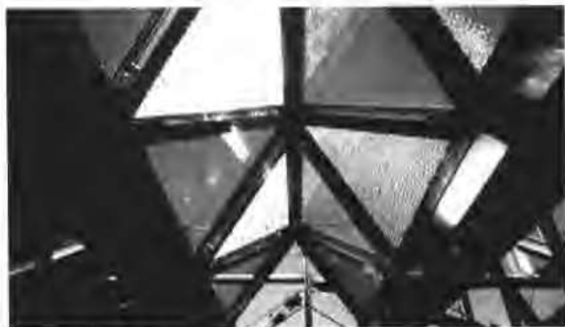
1 在做施工图设计时，多数都是参照足尺的实物模型进行设计。把光照射在天窗采光的蜂窝状百叶窗或层状结构板材上进行研究
