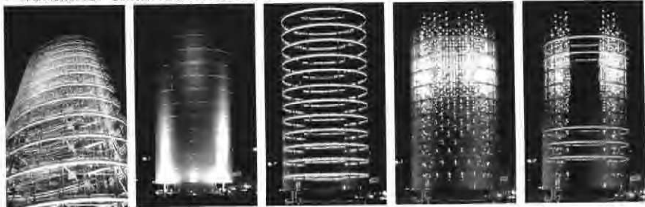
5. 神奈川的排风塔，地铁的排风通道变成了灯光装饰塔
