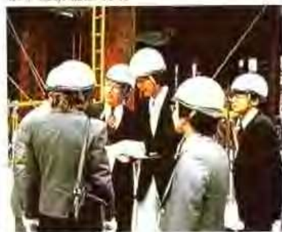
2 距竣工还有23个月时,在设计师的带领下视察施工现场
