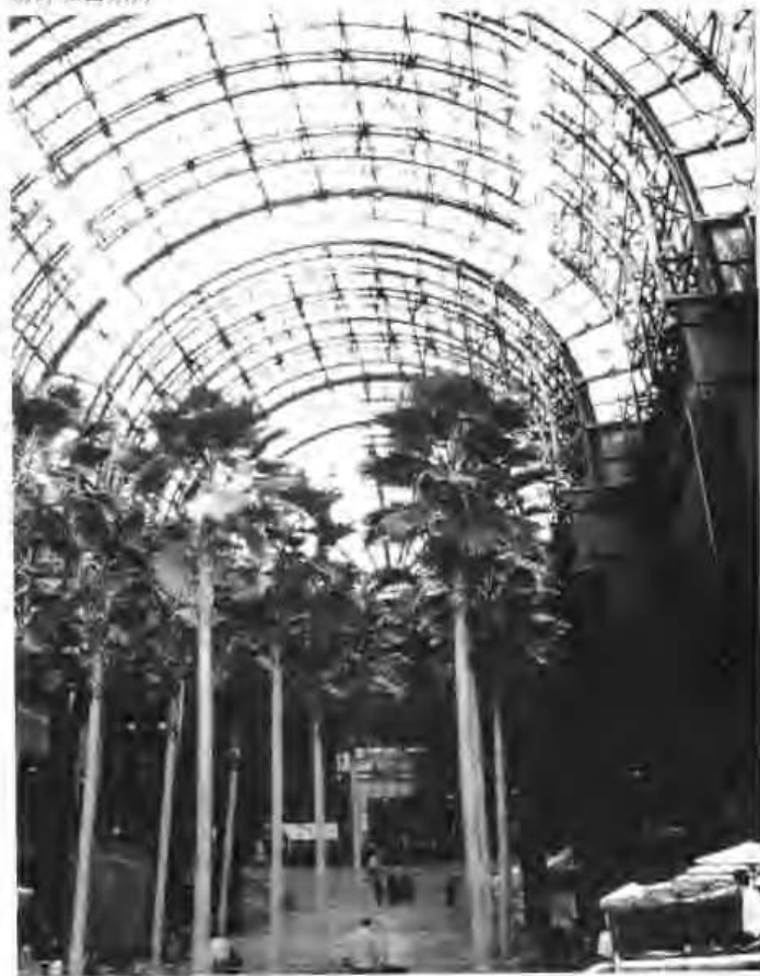
6 世界金融中心里的冬景花园（纽约）在穹顶桁架上安装有金属卤化物灯和白炽灯
