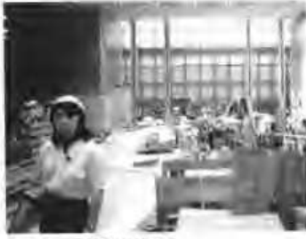
l 施工现场的检查
